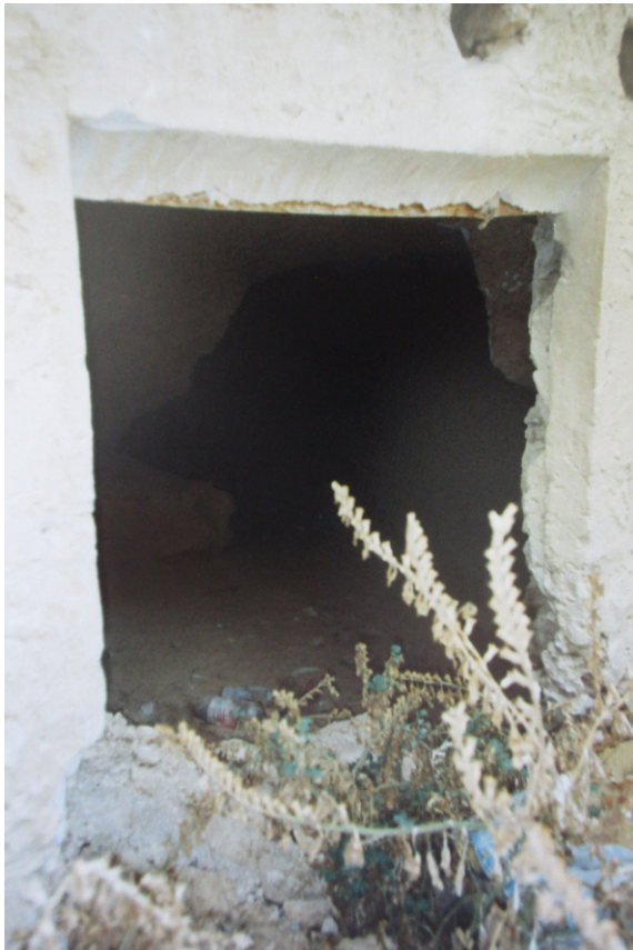
Establo excavado en el interior de una cueva, utilizando el terreno natural, situado en la finca «La Murta», del término de San Vicente del Raspeig. (Foto: Lola Carbonell Beviá. 11 octubre, 1998)
