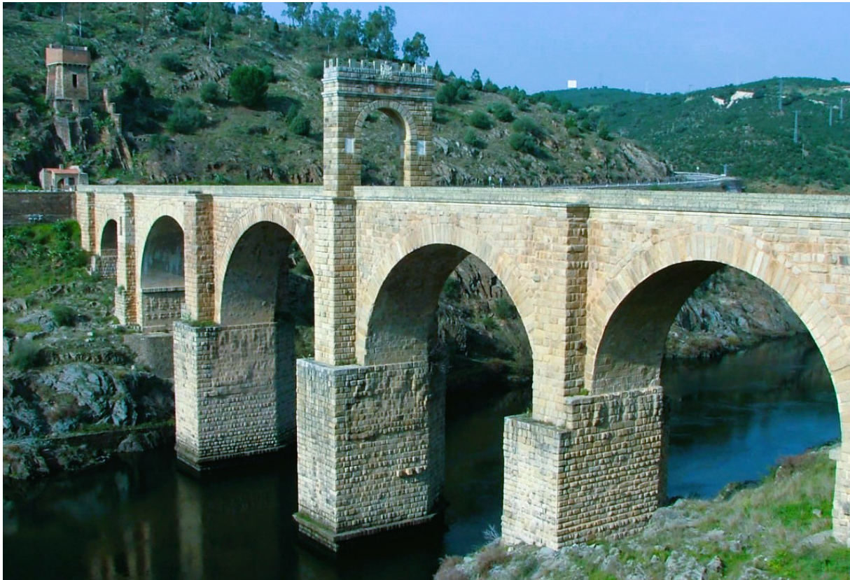
Figura 10. Puente romano de Alcántara
